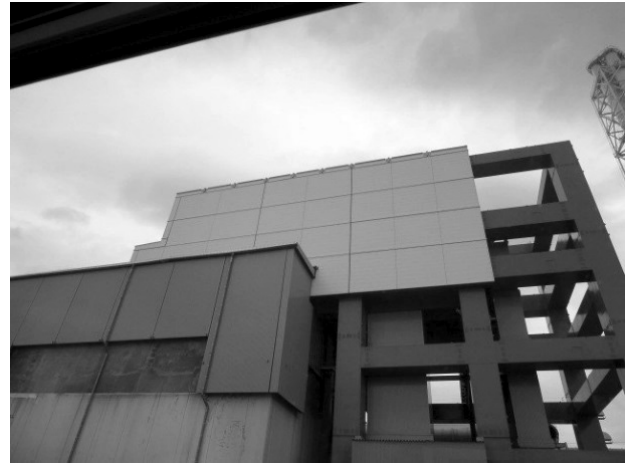
写真5 4号機建屋に隣接する巨大な鉄骨構造物 中に使用済燃料取り出し用のクレーンが 設置されている
