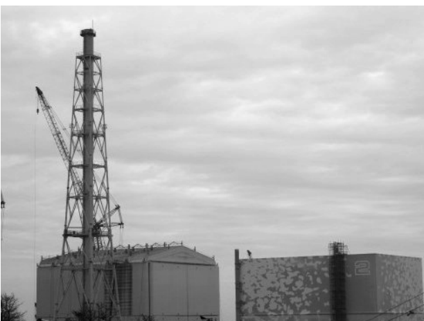
写真4 構内を移動するバスの車内から撮影した 1号機と2号機の原子炉建屋
