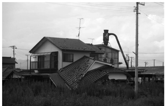
写真8 一階部分が倒壊したままの住宅
